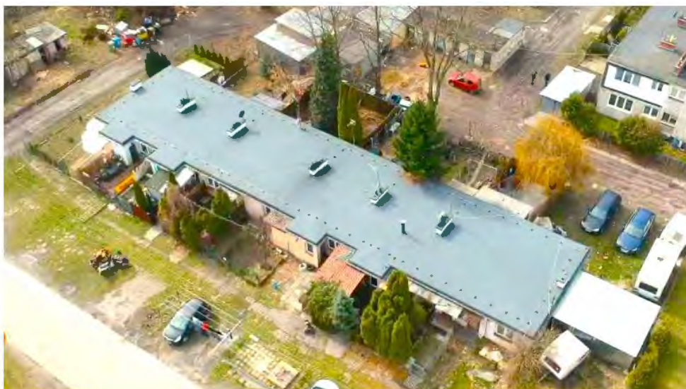
Modernizacja budynku przy ul. Wspólnej 30
