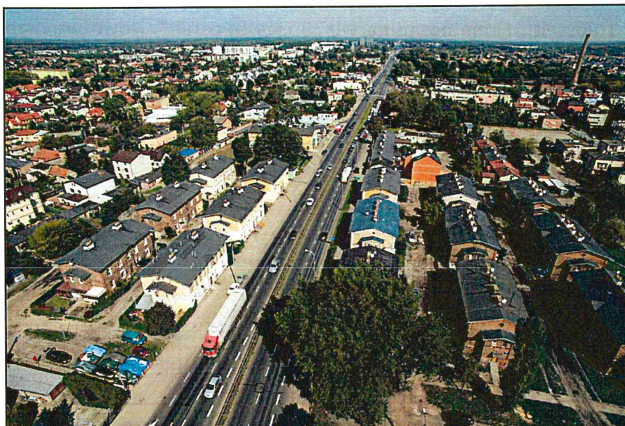
Fot. 6. Marki, zespół budowlany osiedla robotniczego braci Briggsów.
