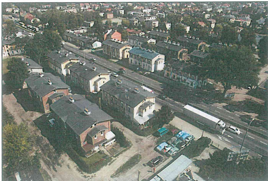
Fot. 5. Marki, zespół budowlany osiedla robotniczego braci Briggsów.
