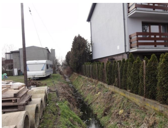
Rów melioracyjny w wschodniej części opracowania (źródło: fot. własne)
